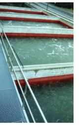
La pollution dissoute sert de nourriture aux bactéries qui se développent dans le BIOSTYR. Les bactéries prolifèrent et sont retirées du cycle sous forme de boues par le lavage cyclique des billes de polystyrène.
